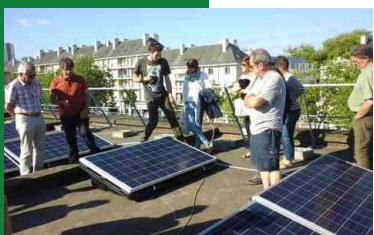
Mise en service des panneaux solaires sur la toiture de la mairie de Lorient, en autoconsommation - juillet 2016 (projet OnCIMè - membre de Taranis)
